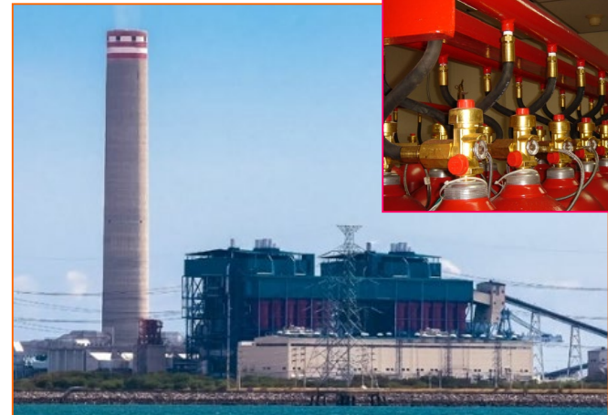
防火システム
