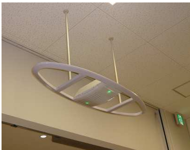
天井式アンテナ 「スーパーアンチボルオーバーヘッドアンテナ」
