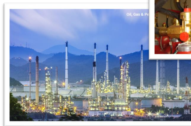
石油ガス化学プラント
