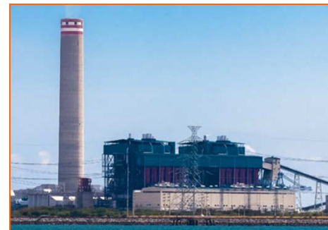
東南アジア発電所
