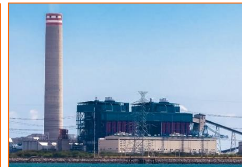
東南アジア発電所
