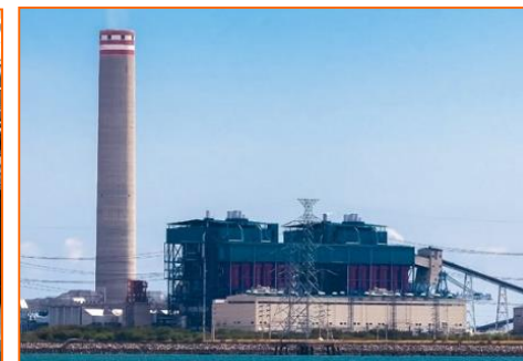
東南アジア発電所
