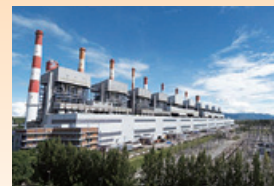
大規模火力発電所
