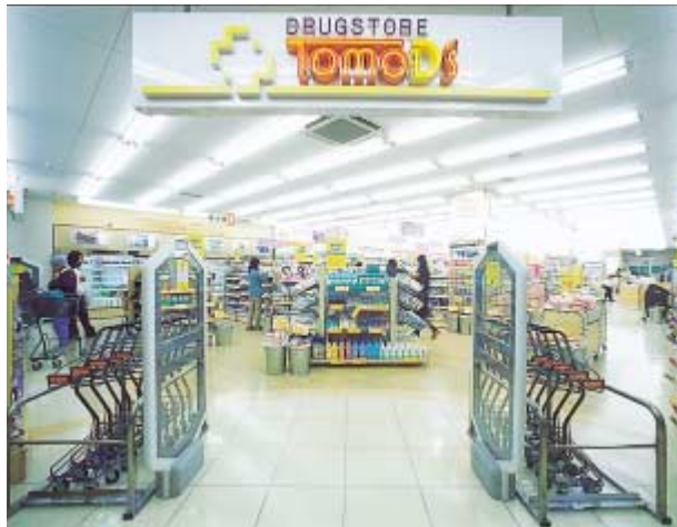
商品監視システム設置風景
